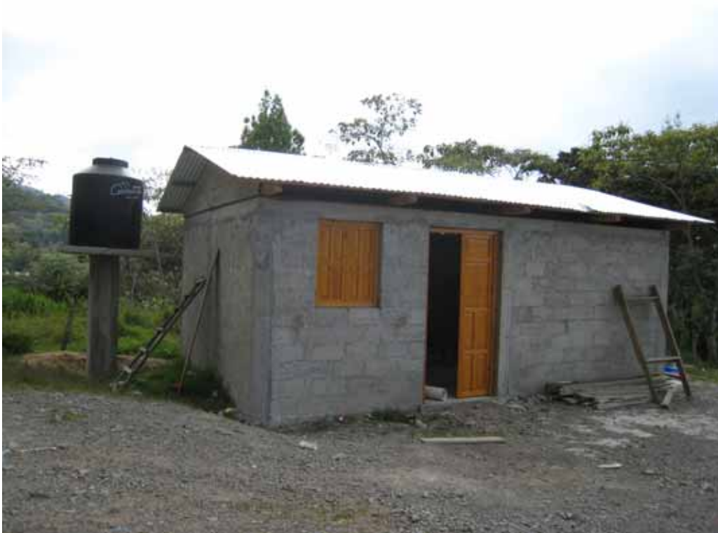
(写真) MV の一次加工施設 (建設中)
