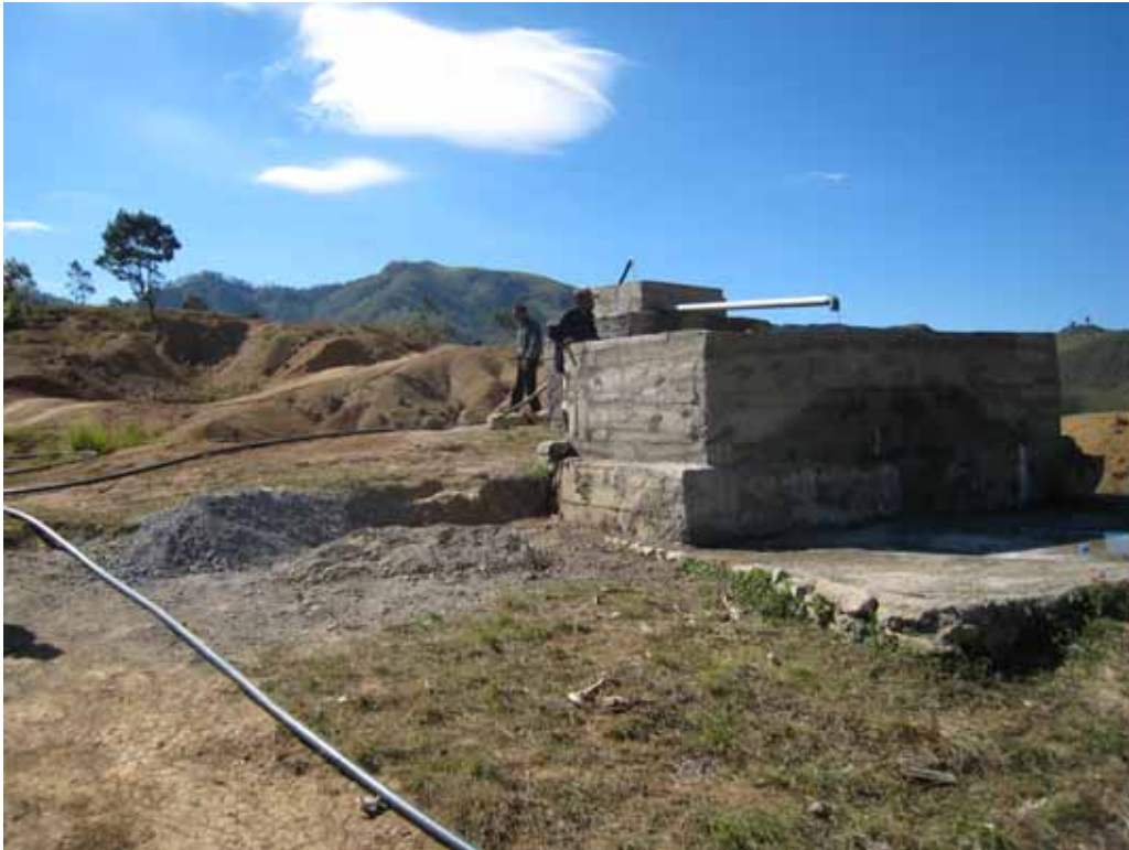
(写真) リタの一次加工施設 (建設中)
