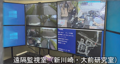
遠隔監視室（新川崎・大前研究室）
