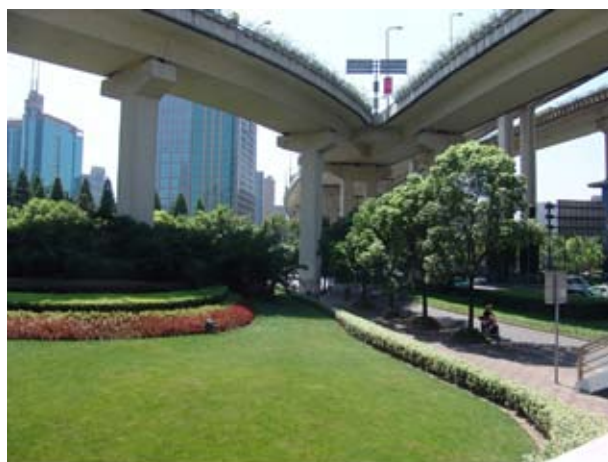
写真 3 広場公園と高架橋
