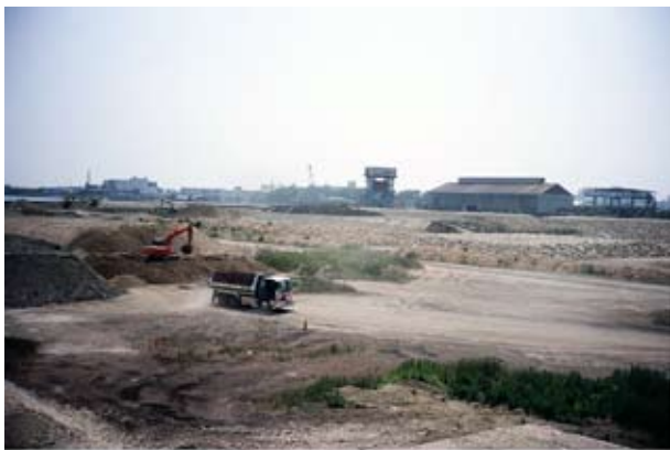
写真1 整備中の尼崎の森中央緑地
