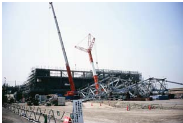
写真2 建設中のスポーツ施設
