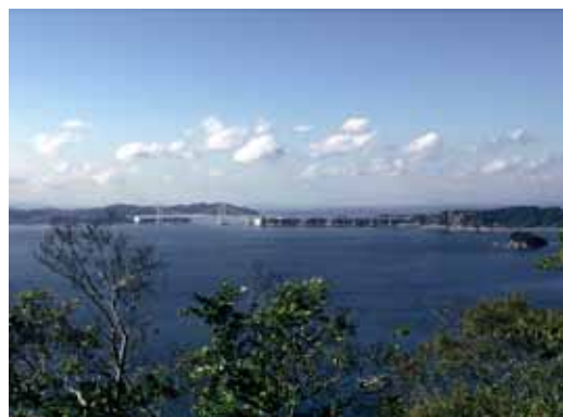
写真 4-6-2. 兵庫県南あわじ市田尻
