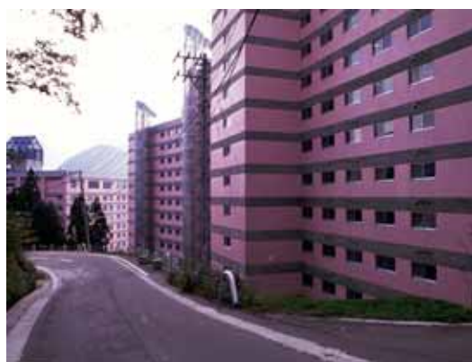
写真 4 - 4 - 2 . 新潟県南魚沼郡湯沢町布場
